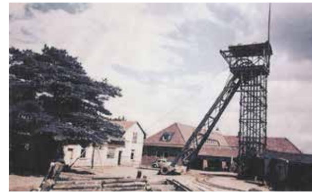
Die Grube Friedberg vermutlich kurz vor der Stilllegung Anfang 1961. Es ist das einzige bekannte Farbbild der Anlage.
