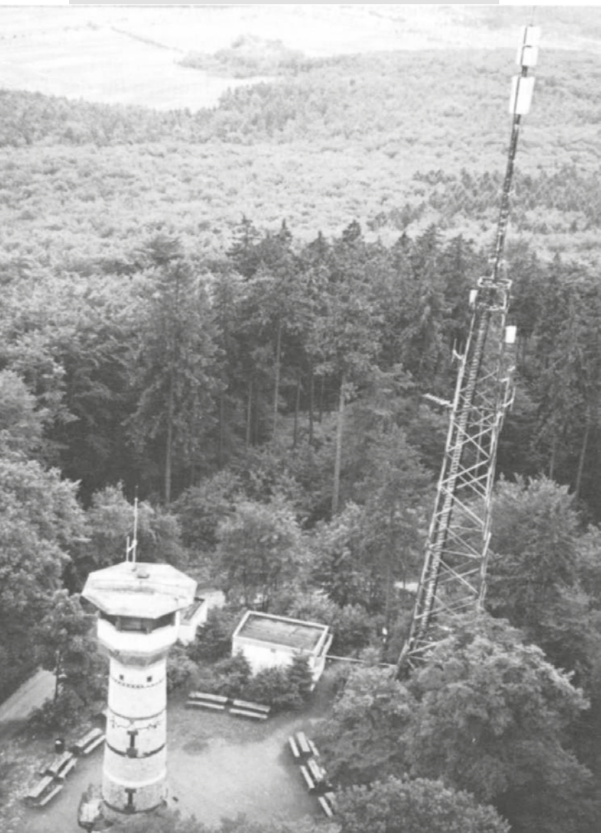
Ein 1964 errichteter 32 Meter hoher Stahlgittermast und die Betriebskabine für die Sender standen auf dem Gipfelplateau im Bereich des heutigen Spielplatzes. Foto: Archiv Dünsberg-Verein
