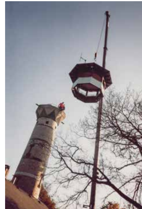
Die marode Holzkuppel wurde im November 1987 abgenommen und durch eine höhere ersetzt. Foto: Archiv Dünsberg-Verein
