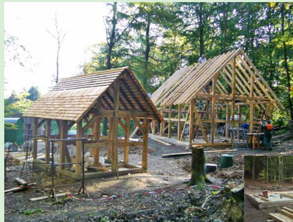
Die ehrenamtlichen Helfer des Dünsberg-Vereins haben innerhalb von 10 Wochen das Holzfachwerk für die drei Gebäude errichtet.
