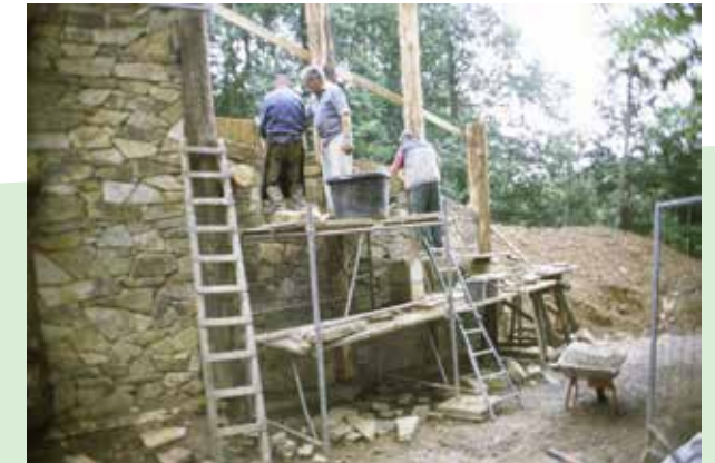
Die Räume zwischen den Pfosten wurden mit Grauwacke-Bruchsteinen ausgemauert und verfugt.
