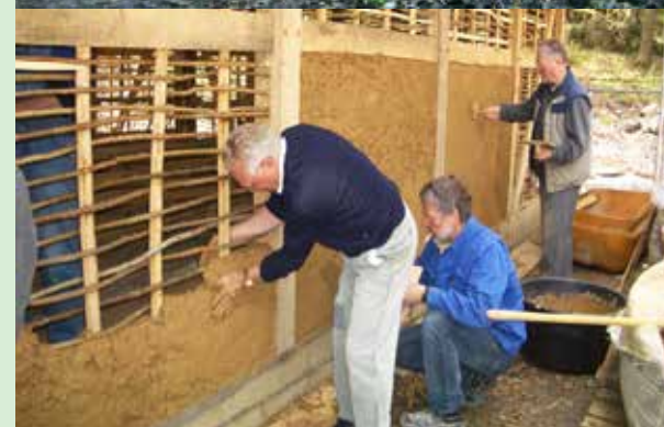
Mitglieder des Dünsberg-Vereins haben die mit Stakhölzern versehenen Gefache mit einem Lehm-Strohgemisch ausgefüllt und dieses glatt gerieben.
