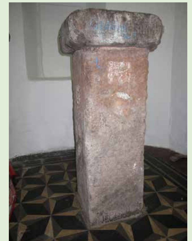
Um 1830 wurde für die Landesvermessung ein Sandsteinpfeiler auf dem Gipfelplateau errichtet. Zentrisch darüber wurde 1899 der Dünsberg-Turm erbaut. Foto: Günter Leicht
