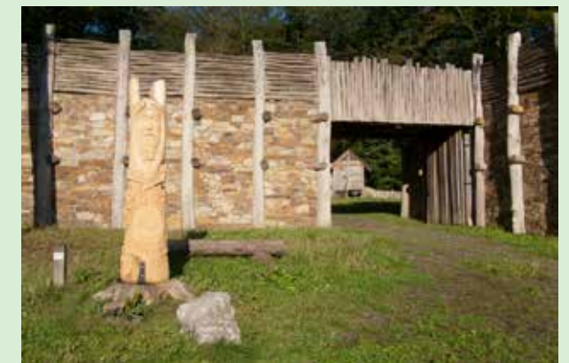
Bruchstein-Mauerwerk füllt die Räume zwischen den mächtigen Eichenpfosten.
