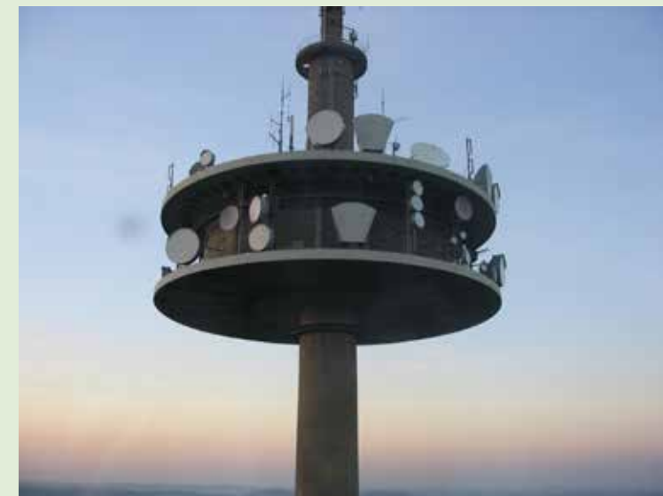
Der Fernmeldeturm auf dem Dünsberg ist auch heute noch ein wichtiger Richtfunkverteilstützpunkt. Foto: Günter Leicht
